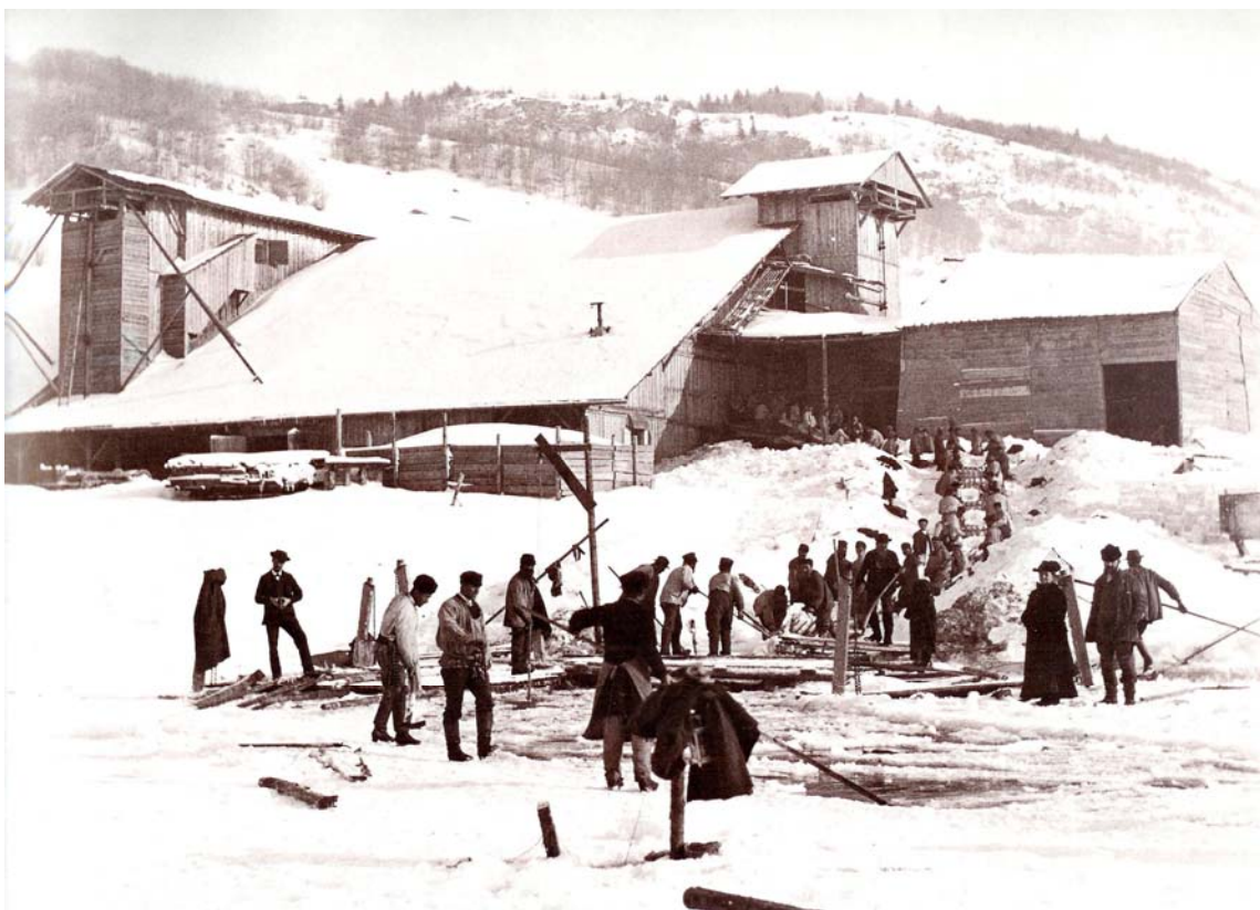
C'est au cours de l'été 1880, suite aux expériences de la première récolte, qu'une adjonction importante fut faite au bâtiment initial du côté de vent. Avec l'installation d'un nouvel entrepôt, mais surtout du carrousel, sorte de tour par où la glace pouvait être montée grâce à la traction animale. Nous sommes ici lors de la deuxième récolte de 1881. Photo Auguste Reymond
